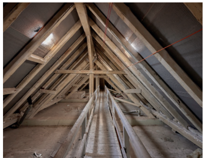
Abb. Dachboden Hauptgebäude (Quelle: Michael Rasche, Dortmund, 2021)
