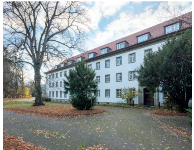
Abb. Hauptgebäude Ostseite (Quelle: Michael Rasche, Dortmund, 2021)
